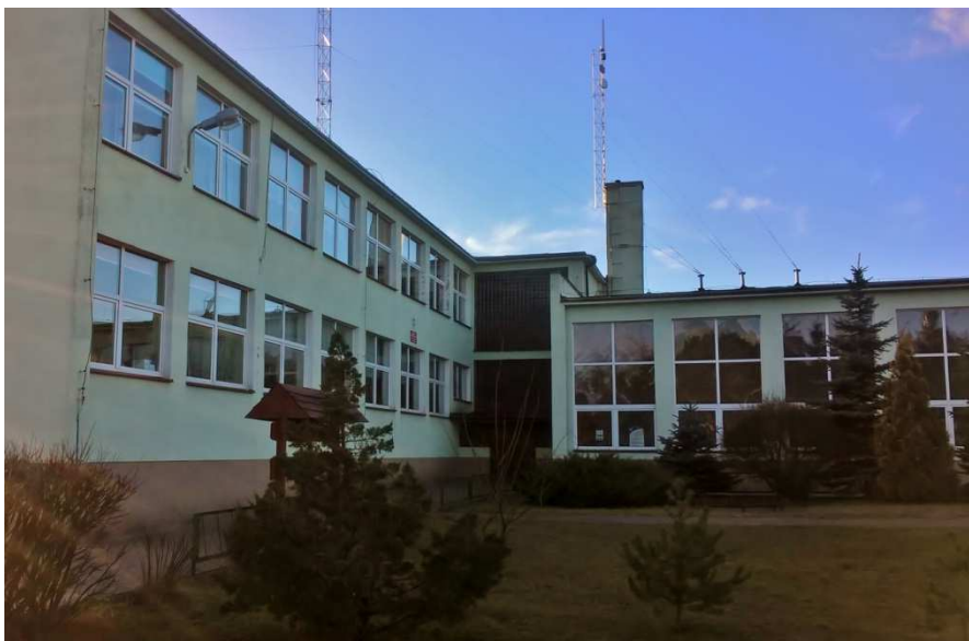
fot. 2: Główne wejście do budynku. Ściana z luksferów do rozebrania i odtworzenia jako murowana ze wstawieniem okien.
