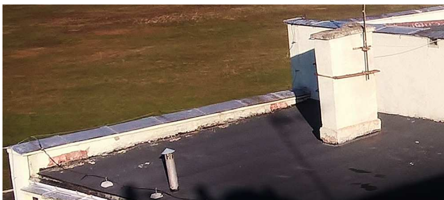
fol. 5: Po dociepleniu dachu wystąpi konieczność podwyższenia ogniomurów.
