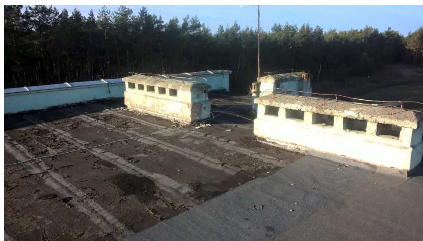
fol. 6: Stan techniczny pokrycia dachowego oraz kominów
